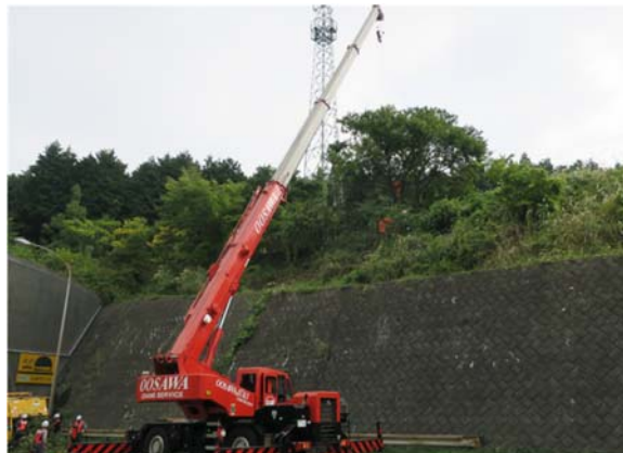
樹木伐採状況
