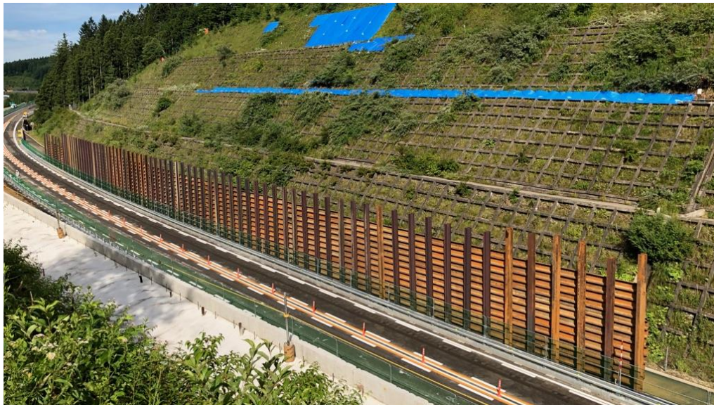
【被災箇所①】 荘川 I C ~ 飛驒清見 I C ( 1 1 0 K P ) の長大切土のり面
