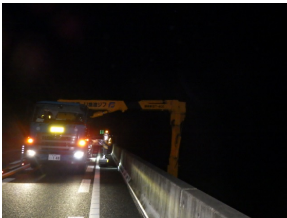
(橋梁点検車を用いた橋梁下面および橋桁の点検)
