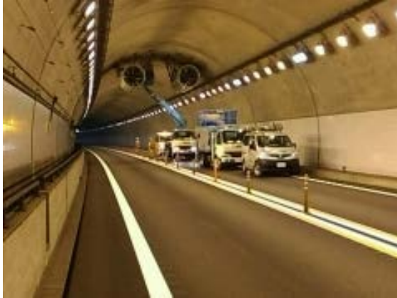
(トンネル換気設備点検)
