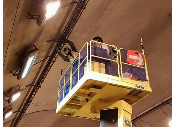
(トンネル照明設備点検)
