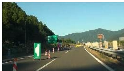
(仮設非常駐車帯設置状況事例)
