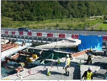
老朽化した床版の撤去
