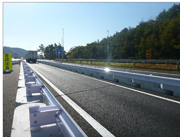
(置き式ガードレール設置状況事例)
