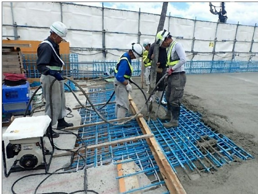
現場打ち床版の施工状況
