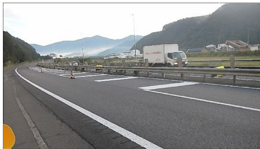
(注意喚起舗装設置状況事例)
