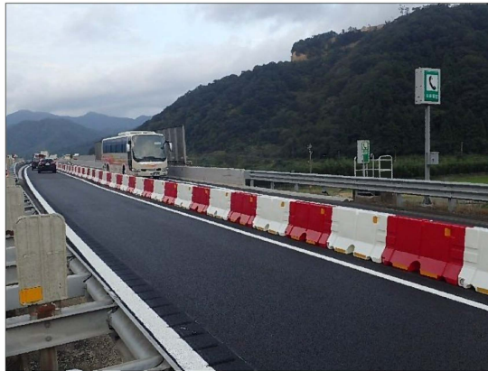
(水充填式仮設防護柵設置状況事例)
