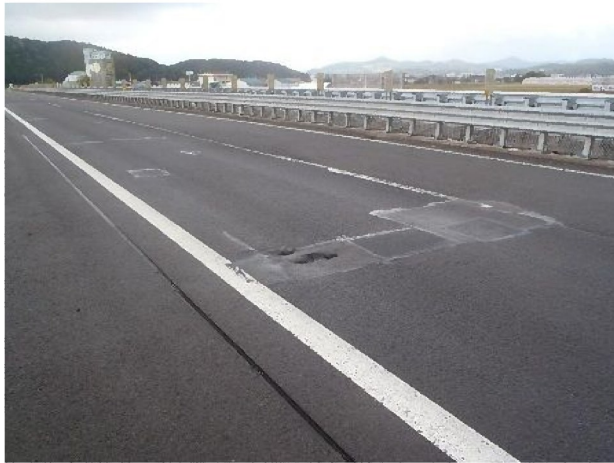
太田高架橋の損傷状況
