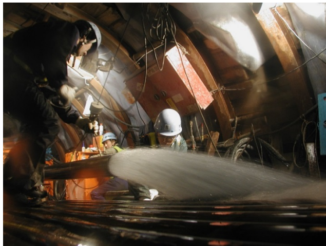
最大で毎分71トンにおよぶ高水圧の湧水の状況
