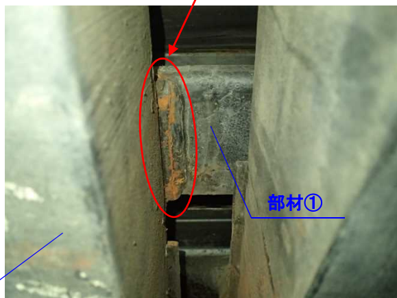
部材①と部材②の溶接部の亀裂
