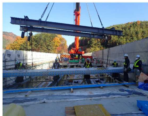
プレキャスト床版の吊り込み状況
