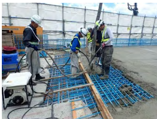
現場打ち床版の施工状況
