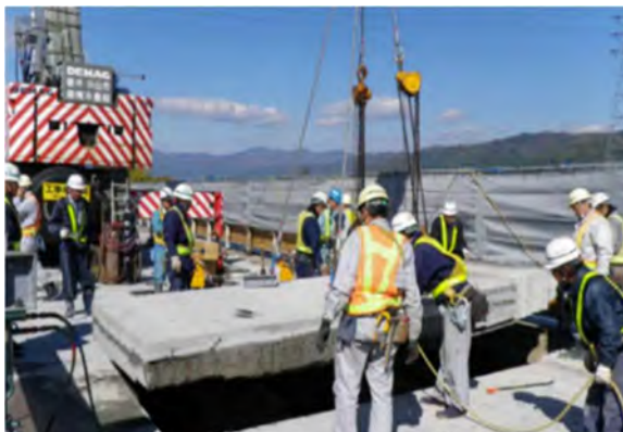
既設コンクリート床版を切断撤去
