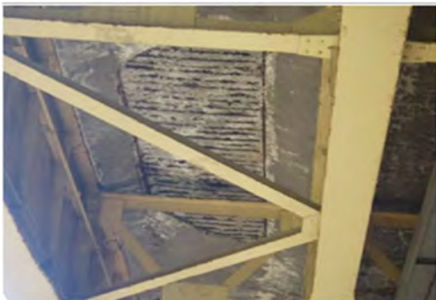
松ヶ平橋の床版下面
