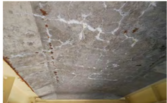
平出高架橋の床版下面
