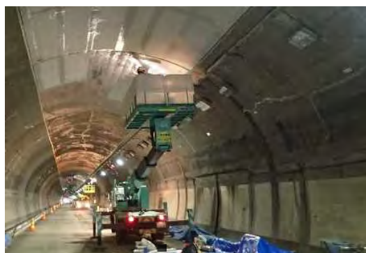
繊維シートの貼付け工事实施状況例
