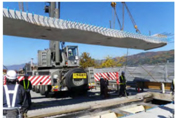
プレキャストコンクリート床版を吊り込み
