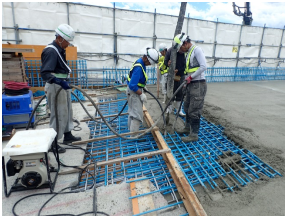
現場打ち床版の施工状況
