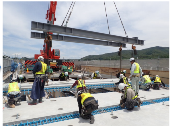
プレキャスト床版の施工状況
