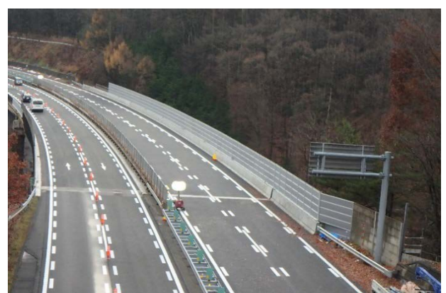
床版取替完了後
