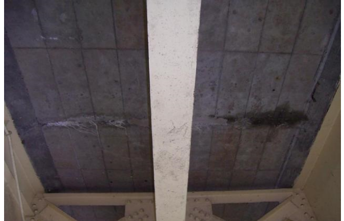
既設床版の損傷状況（ひびわれが床版を貫通しており、床版下面に漏水が発生している）
