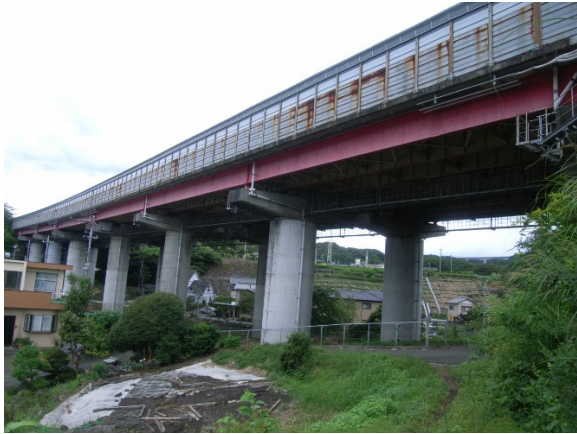
赤淵川橋 全景（東京側から）
