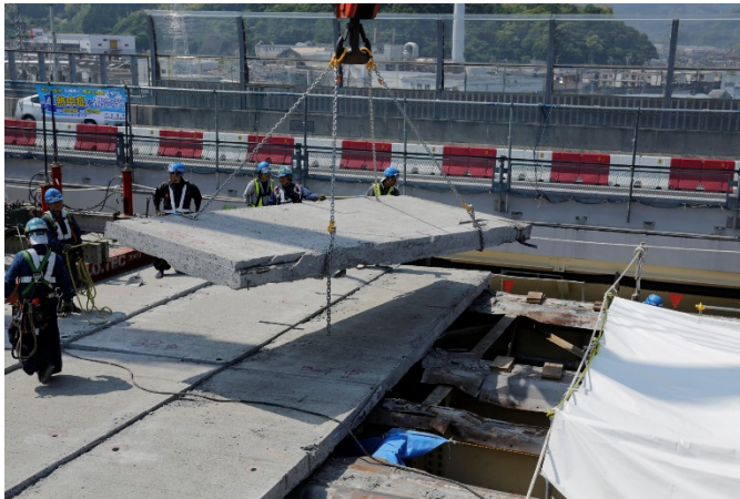
老朽化した床版の撤去
