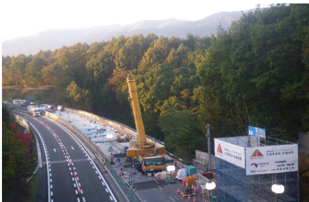
床版取替工事 全景
