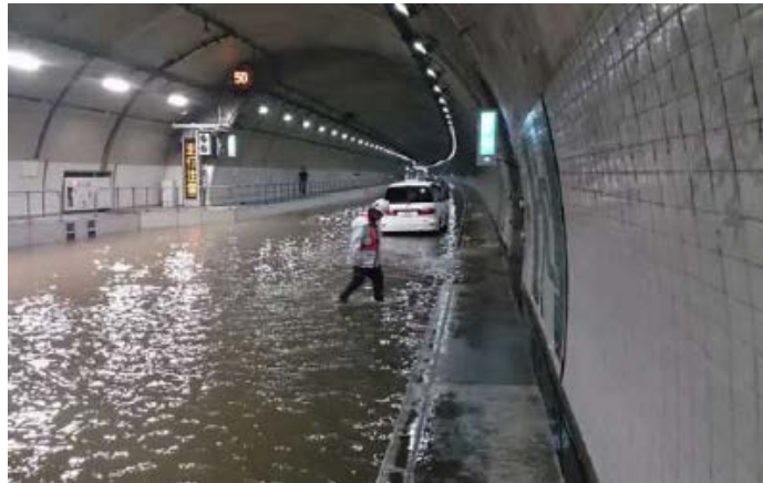
(雨水の流入により、本線内が冠水した状況(愛川トンネル内))
