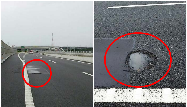
(路面損傷の発生状況①)
