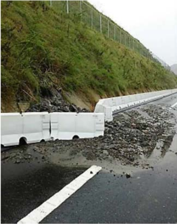
(集中豪雨後ののり面の小崩落)
