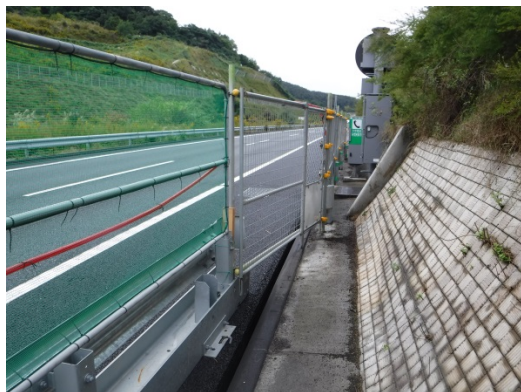
（路肩固定規制の設置状況）
