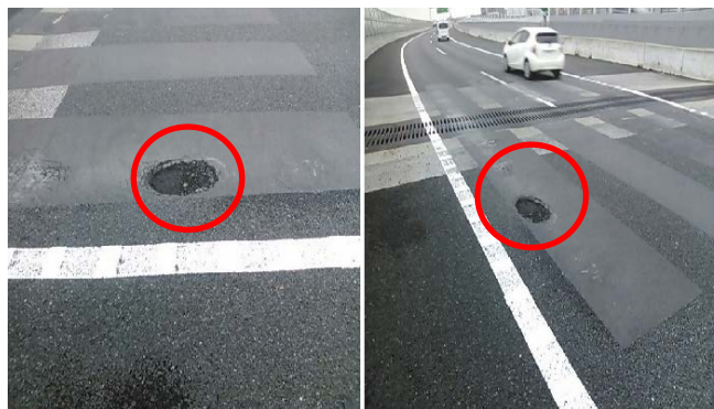
(路面損傷の発生状況②)
