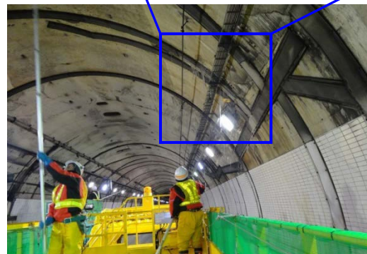
トンネル内のツララ落とし状況
