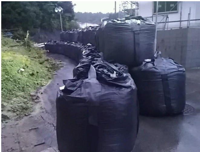
応急復旧後の状況（10/25 9時現在）
