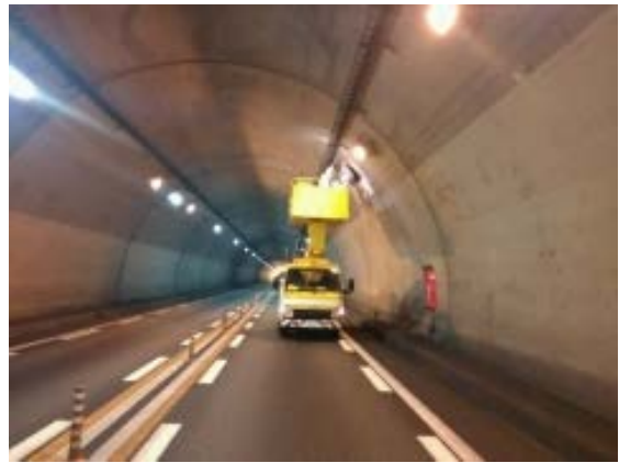
(トンネル照明点検)
