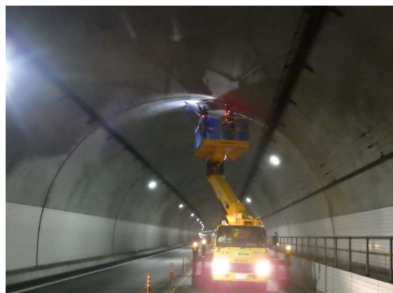
(高所作業車を用いたトンネル覆工点検)
