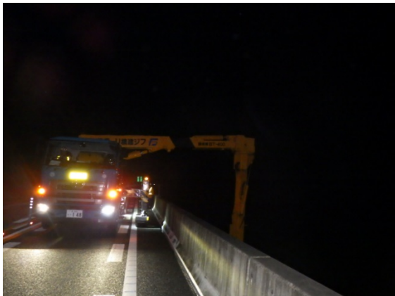
(橋梁点検車を用いた床版下面および橋桁の点検)
