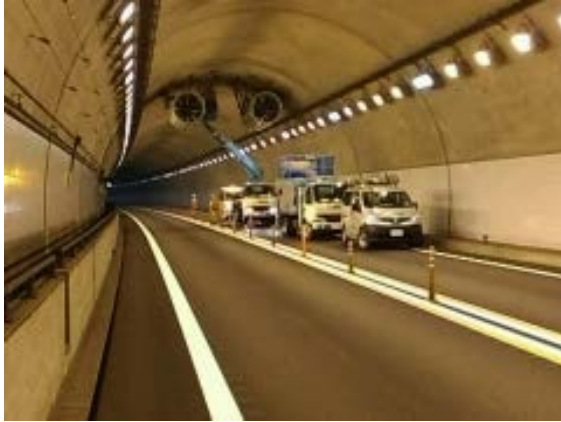
(トンネル換気設備点検)
