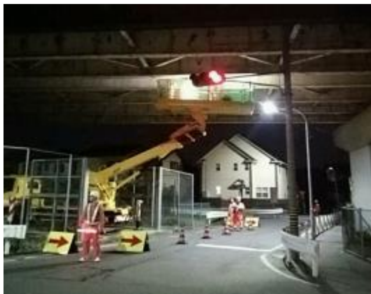
緊急点検実施状況
