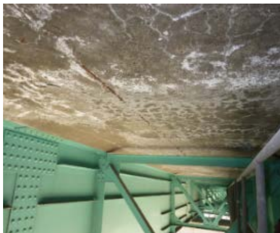
床版下面のひび割れ
