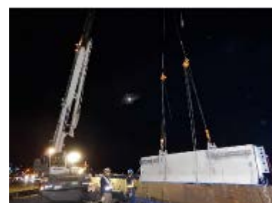
プレキャスト壁高欄架設状況
