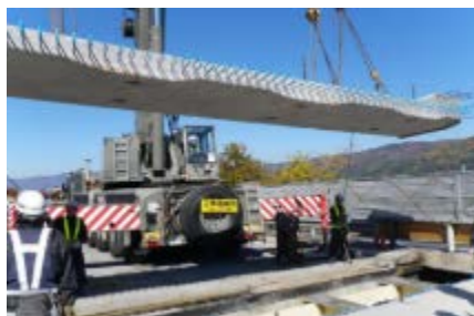
プレキャスト床版架設状況
