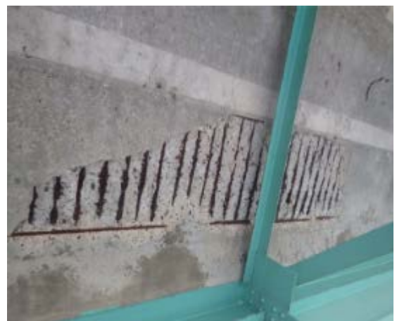
床版下面のコンクリートのはく離
