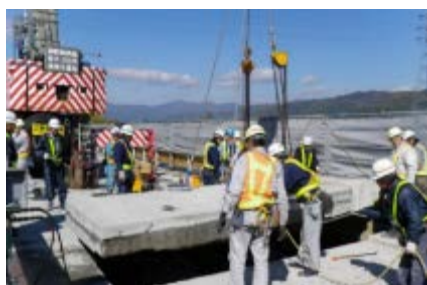
既設コンクリート床版撤去状況
