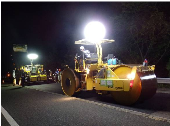
《舗装補修工事》
