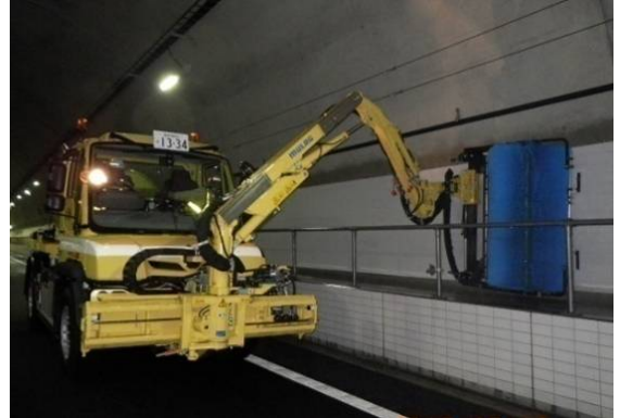
《トンネル側壁清掃》
