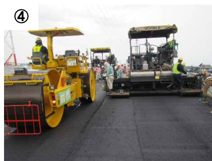
④ 試験舗装の状況 (2017年6月撮影)
