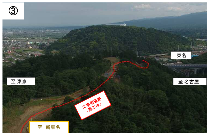
山北町域向原工専用進入路の整備状況 (2017年7月撮影)
