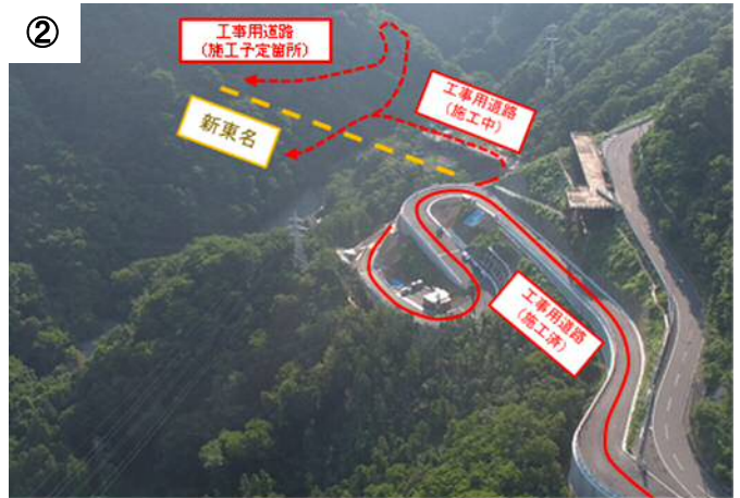
松田町域中津川工専用進入路の整備状況 (2017年7月撮影)
