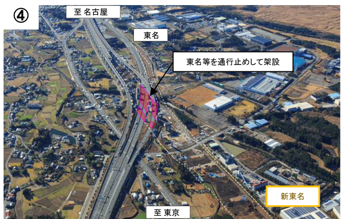
御殿場JCTの整備状況 (2017年7月撮影)
