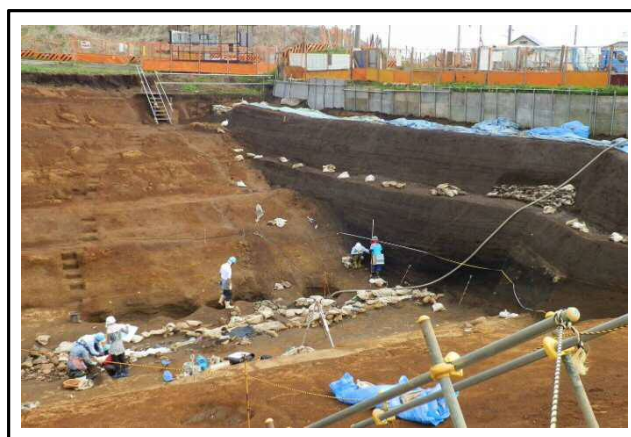
埋没谷地形の状況(西富岡地区)
