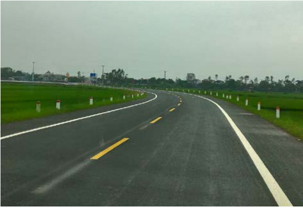
【写真①】 新設バイパス部
