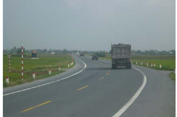
【写真④】 通行状況（新設バイパス）
