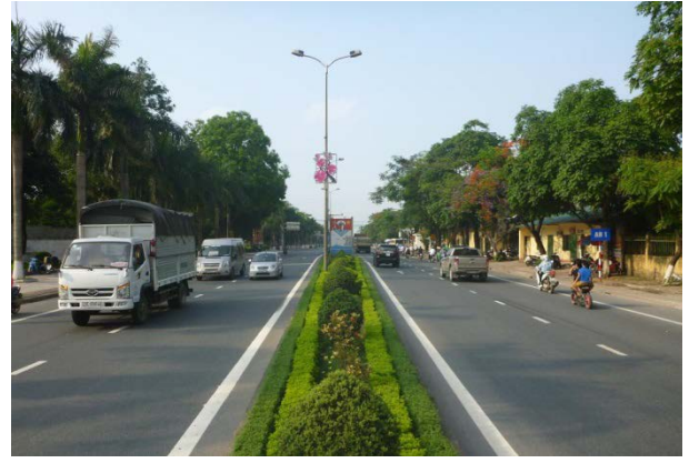
【写真②】 既設国道改良部
