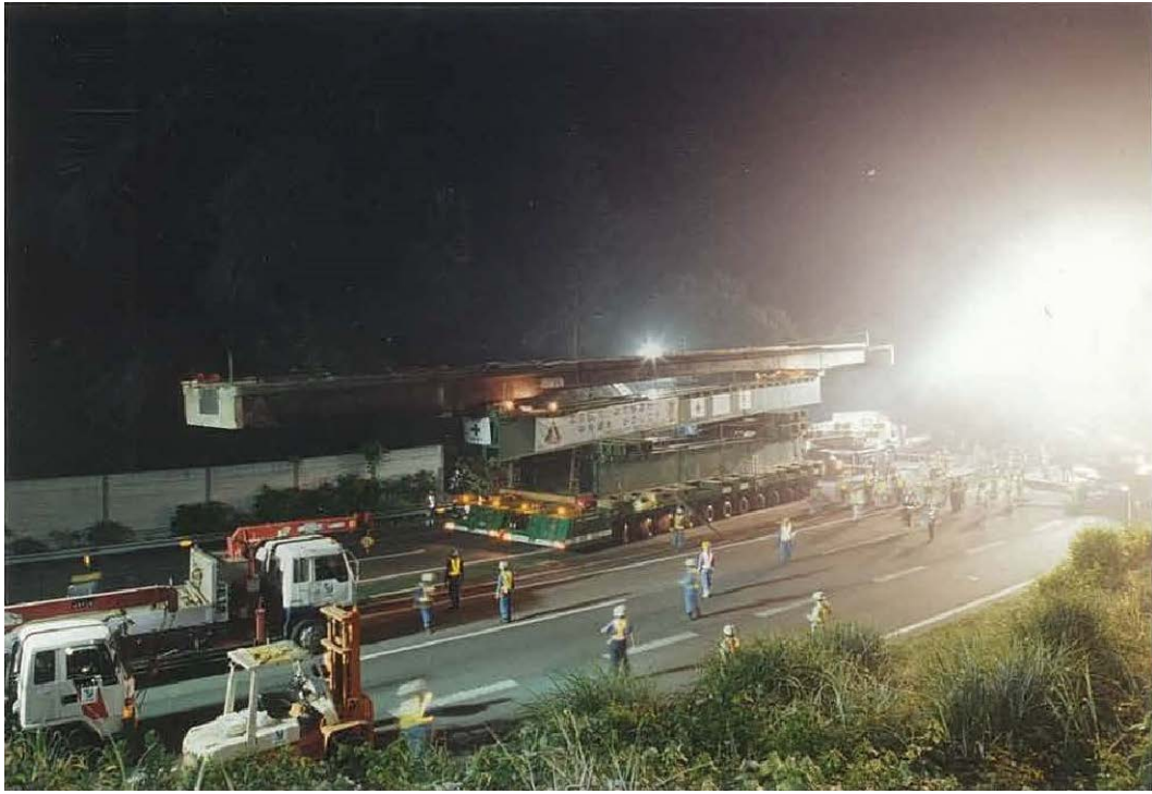
多軸台車による橋桁撤去事例
