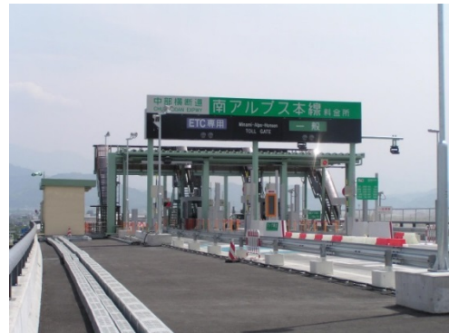
南アルプス本線料金所【撤去予定】
