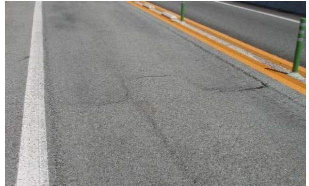
舗装損傷状況
