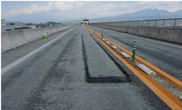
舗装損傷状況
