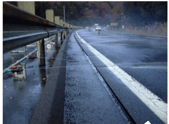
定置式溶液散布状況
