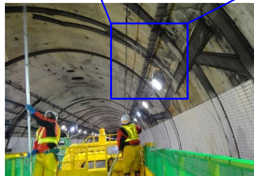
トンネル内のツララ落とし状況
