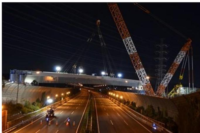
架設工事のイメージ(大型クレーン一括架設)
