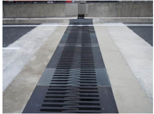
④工事完了
