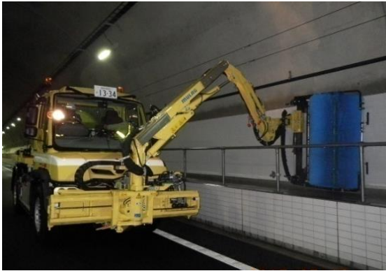
《トンネル側壁清掃》
