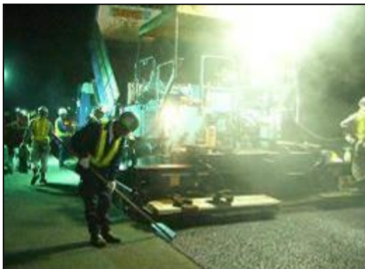
《舗装補修工事》
