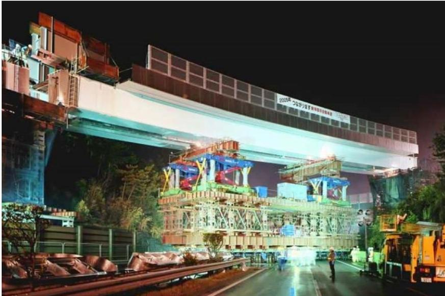
多軸式移動台車を使用した架設工事のイメージ
