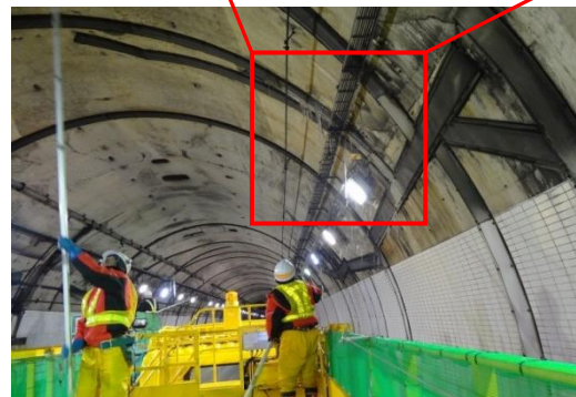
トンネル内ツララ落とし
