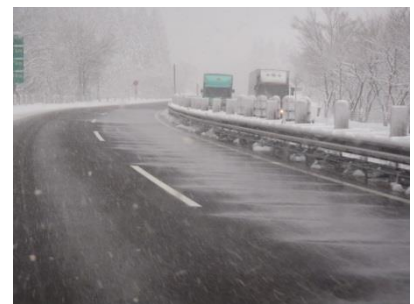
散水消雪状況
