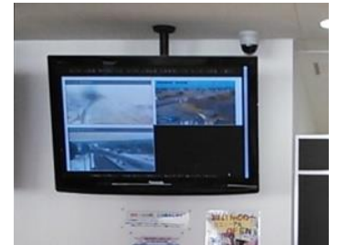
路面状況画像の提供
