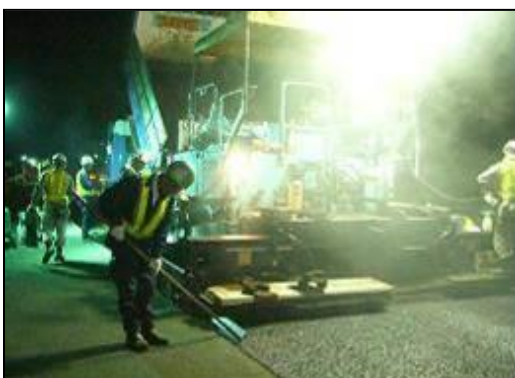
《舗装補修工事》
