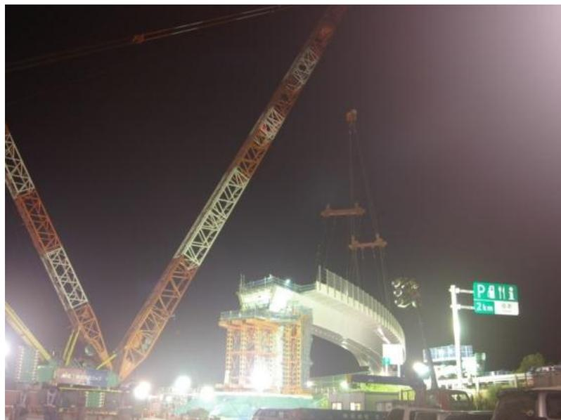
大型クレーンを使用した架設工事のイメージ（東海環状自動車道 養老ジャンクションの架設状況）
