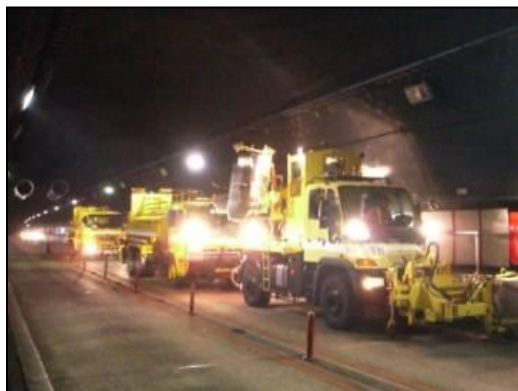
《トンネル側壁清掃》
