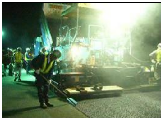
《舗装補修工事》
