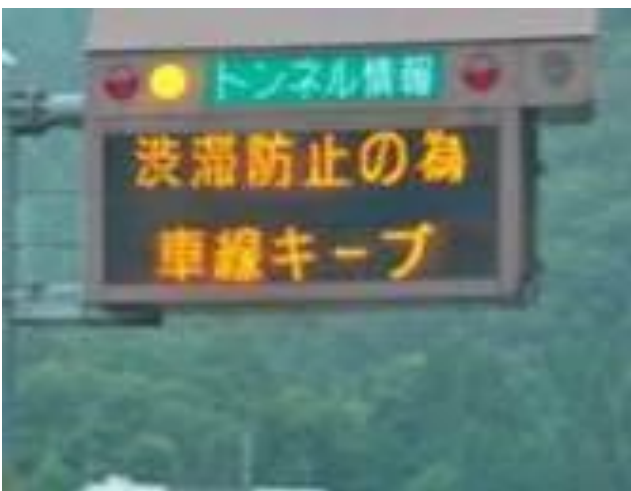
【トンネル入口部での速度低下注意喚起】
