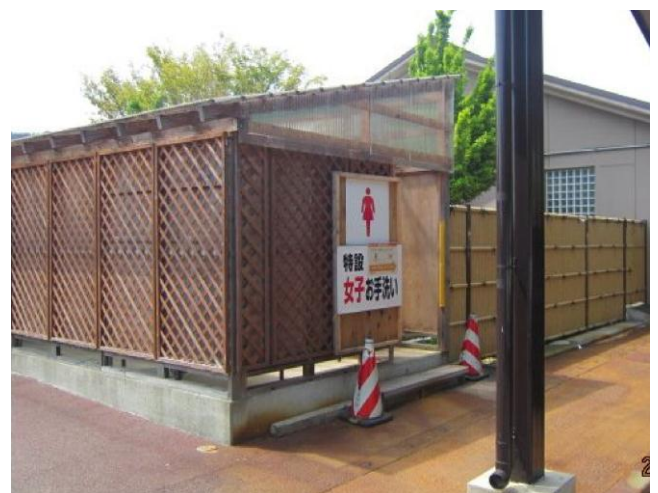
【特設トイレの設置】
