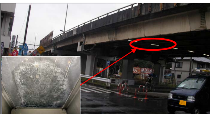
国道16号 橋本陸橋
