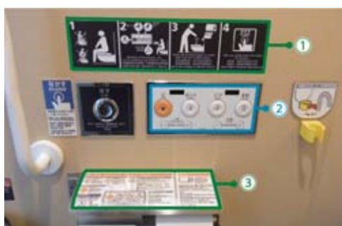
■従来の操作パネル ①トイレの使い方説明とピクトグラム ②温水洗浄便座の操作 ③温水洗浄便座の操作説明
