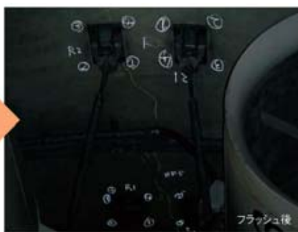
「フラッシュマーカ―」でマーキングをした場合 (ライトで照らしたりカメラのフラッシュを当てたりすることでマーキング箇所が光って見える)
