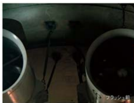
一般的なチョークでマーキングをした場合 (トンネル等の暗所ではマーキング箇所が分かりにくい)
