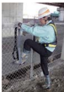
金属のフックを柵の胴縁にかけ、ベルトの輪の部分（あぶみ）に足をかけます。
