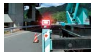
重機のアウトリガーに設置
