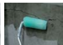
AT388（塗布浸透接着工法）
