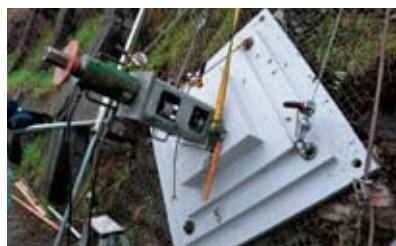
アンカーテンドン切削状況
