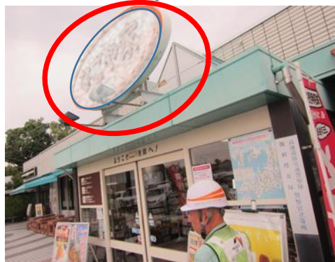
〔 二重の安全対策が未実施の テナント看板を確認 〕
