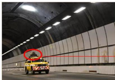
トンネル内の撮影状況
