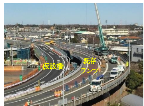
(仮設橋の活用)
