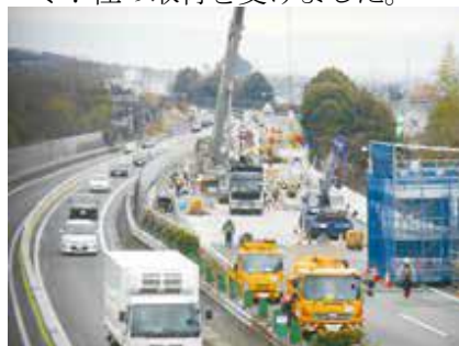
(床版取替工事と対面通行)
