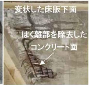
【写真2】橋梁の鉄筋コンクリート床版の塩害劣化事例 ※2
