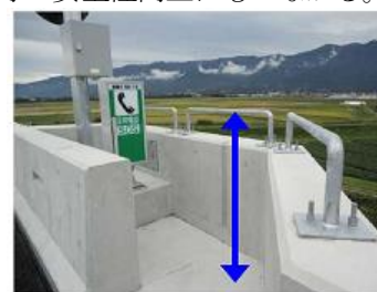
非常電話周辺手摺り（H=100）
