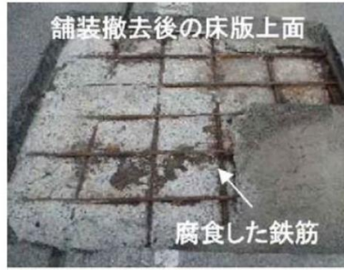
【写真2】橋梁の鉄筋コンクリート床版の塩害劣化事例 ※2
