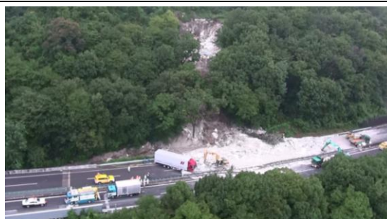
中央道本線から約60m離れた道路区域外の窪地に山積みされていた窯業廃材等が本線に流入し、車教台が巻き込まれたもの。
