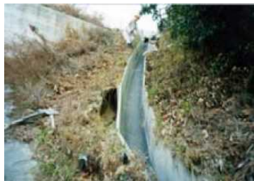
排水溝周りの損傷
