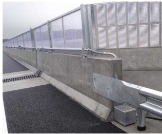
剛性防護柵 (路側用)フロリダ型
