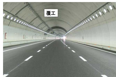
※NATM(ナトム)工法によるトンネル
