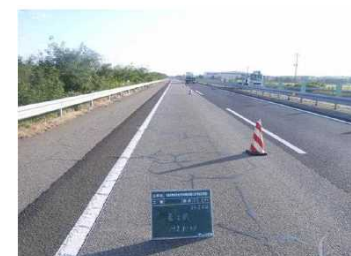
舗装表面のひび割れ
