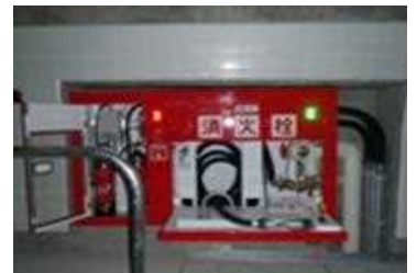
消火栓(給水栓付)
