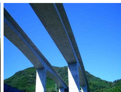
コンクリート橋 (PC箱桁橋)
