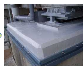
支承の取替及び 沓座の表面被覆
