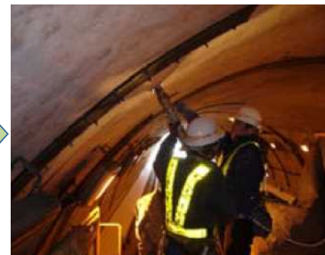
背面空洞注入
