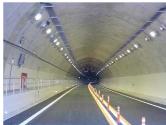
トンネル照明
