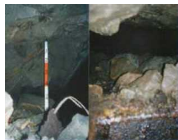
トンネル覆工背面空洞
