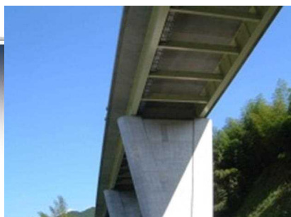
鋼橋 (鋼2主桁桁橋)
