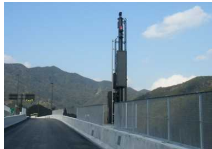
逆走防止設備
