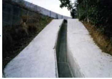
コンクリートシール施工
