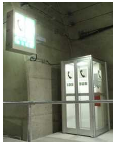
非常電話 (左:トンネル 右:明かり部)
