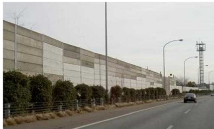
コンクリート板
