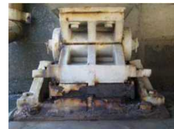
漏水による支承の劣化
