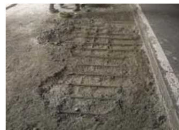
床版上面の劣化
