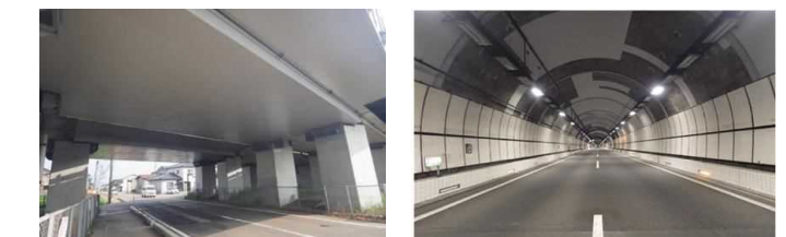
剥落対策工(連続繊維シート)施工後
