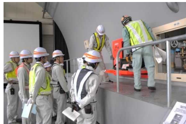
◀ トンネル消火栓点検・操作訓練 ▶
