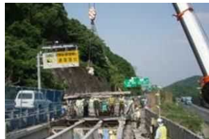
《床版撤去状況》
