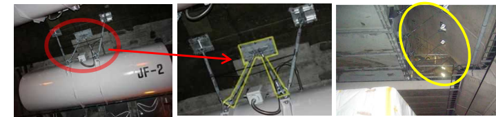
ジェットファンの取付状況
