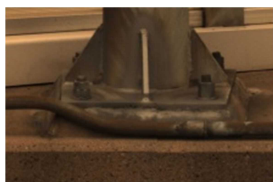
路側付属物(支柱)の状況
