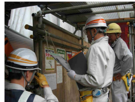
《安全パトロールの状況》
