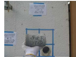
《コア抜き供試体》
