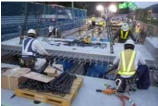
《PC床版施工状況》
