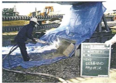
圧縮強度試験体吹付状況
