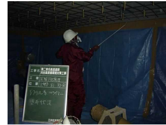
施工中の様子
