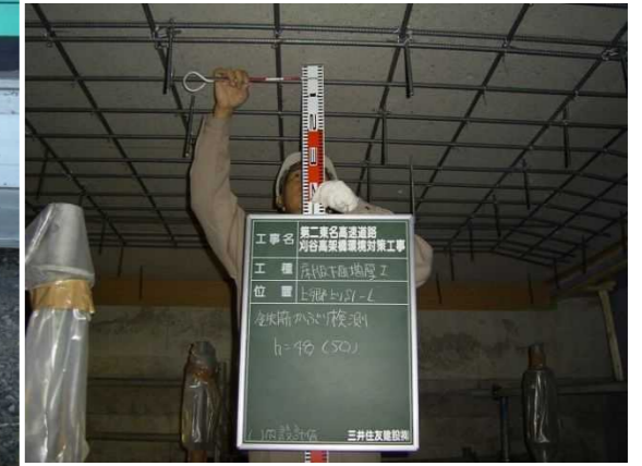
鉄筋組立完了(立会検査)
