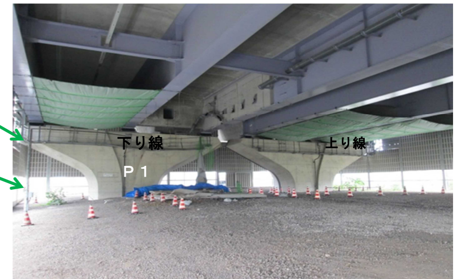
写真-4 遮音壁内部
