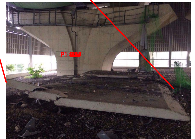
写真—2 床版下面吹付コンクリートはく離・落下状況写真
