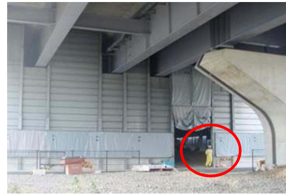
(上郷大成高架橋の出入口の監視状況)
