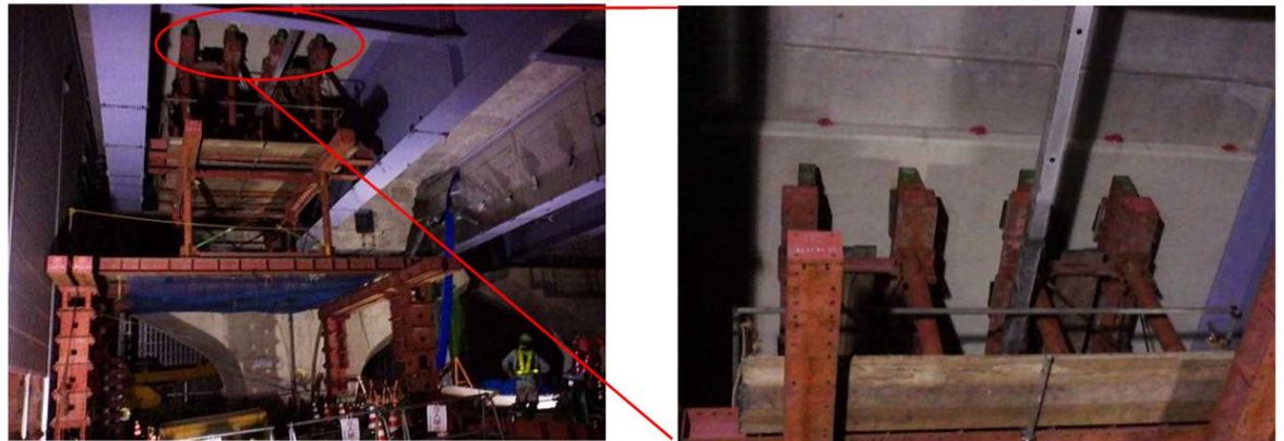
(上郷大成高架橋 下り線の仮受状況)
