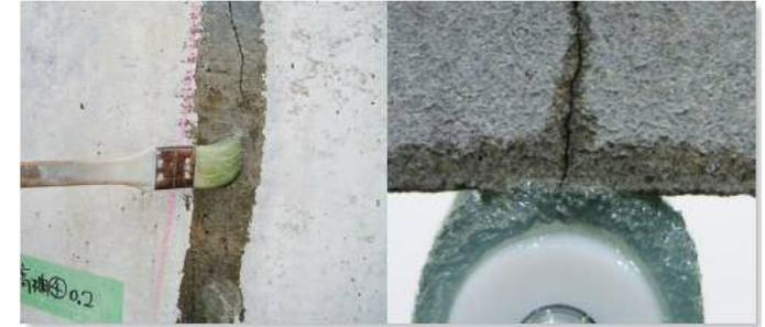
コンクリートひび割れ等の補修用接着剤
