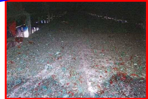
除去塗膜(塗膜くず)の堆積状況
