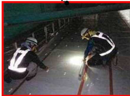
養生シート設置
