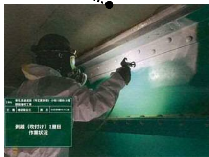
塗膜剥離剤の塗布
