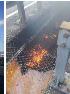
写真2 火災状況 [本線から]
