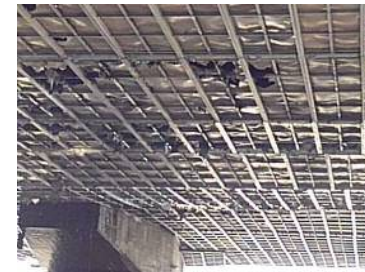
写真4 足場の損傷状況[下面から]
