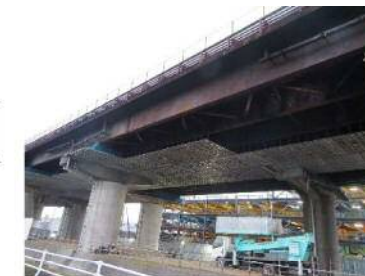
写真6 足場の撤去状況
