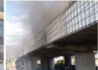
写真3 火災状況 [本線外から]
