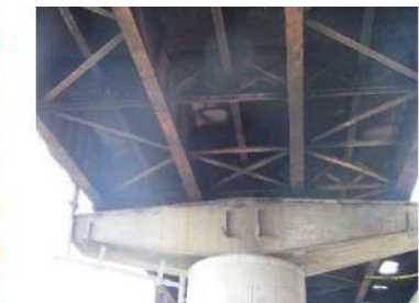
写真7 足場の撤去完了状況
