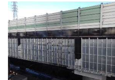
写真5 足場の損傷状況[側面から]
