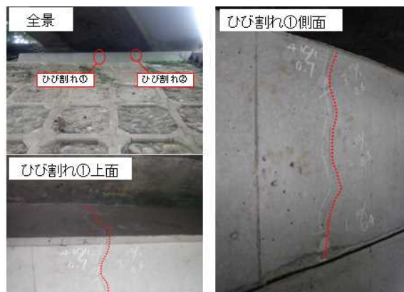
図1 緑橋A1橋台にひび割れ
