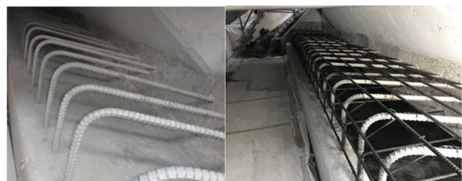
鉄筋の無い状態
