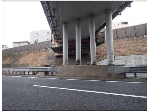
耐震補強前（他の工事の事例）
