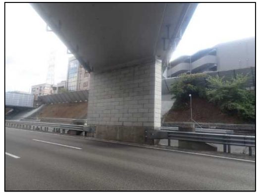
耐震補強後（他の工事の事例）
