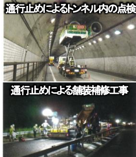
通行止めによるトンネル内の点検 通行止めによる舗装補修工事 4車線化 長期間の通行止めが不要に
