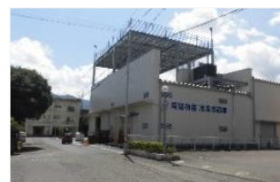
尾鷲物産(株) 急速冷凍保管庫
