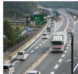
安定輸送が実現した紀勢自動車道
