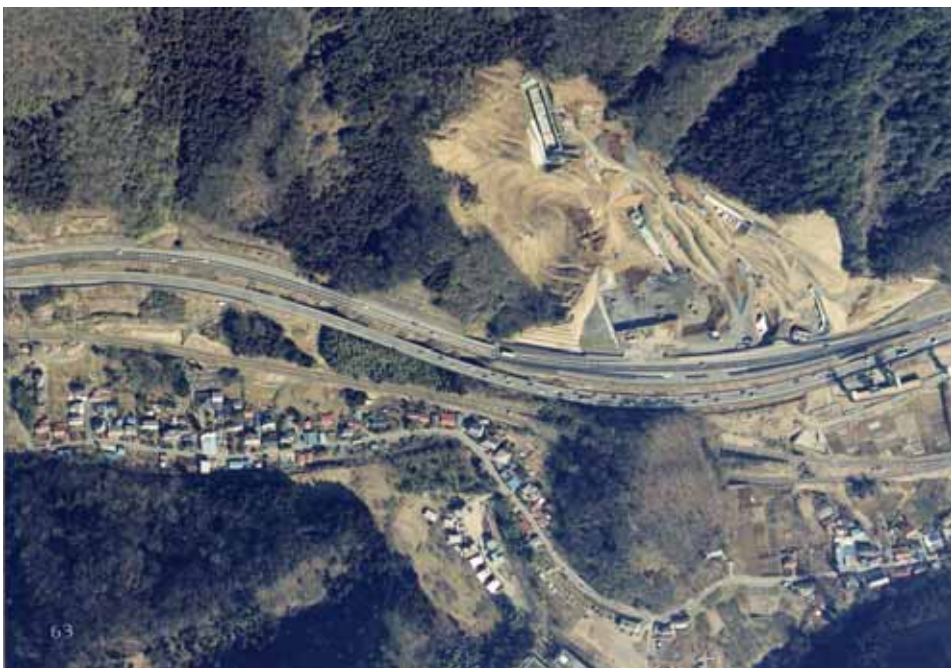
施工中の状況(2000年)
