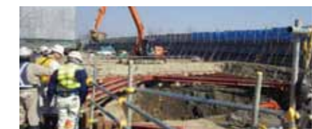
安全パトロール実施状況
