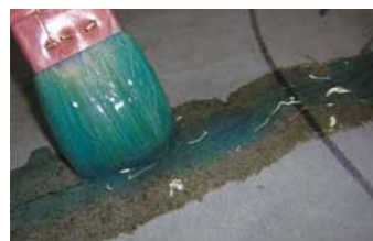
ひび割れ浸透接着剤施工状況
