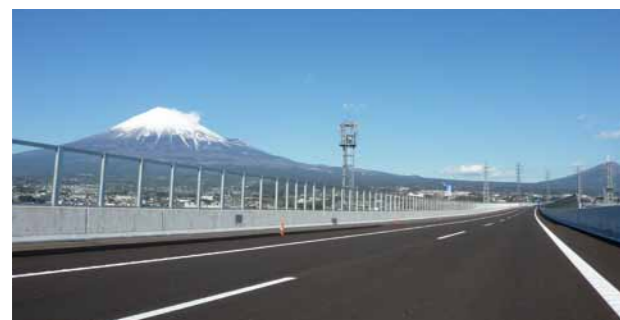
景観に配慮し、透光性遮音壁を設置(新東名 富士市内)
