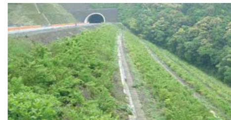
のり面の樹林化(建設時)
