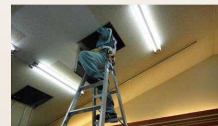
商業施設の建物の点検状況
