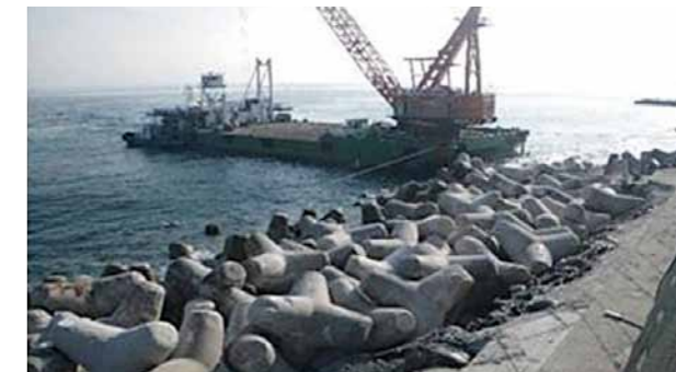
西湘PA護岸工の応急復旧完了状況
