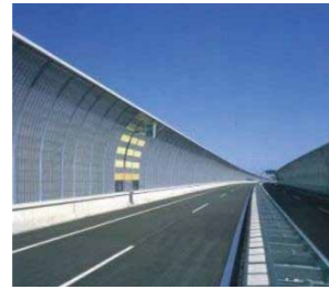
遮音壁の設置状況
