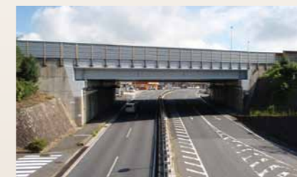
コンクリートのはく落対策実施状況
