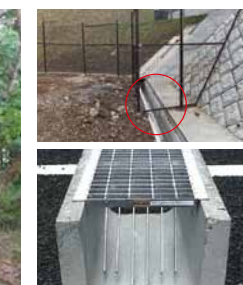
排水溝の動物侵入対策例
