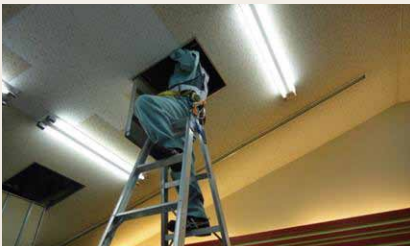
商業施設の建物の点検状況
