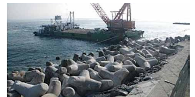
西湘PA護岸工の応急復旧完了状況
