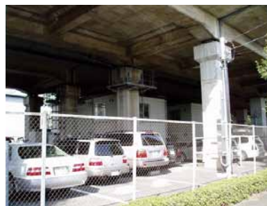
高架下駐車場
