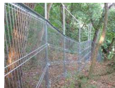
大型動物対策例(立入防止柵の高上げ)
