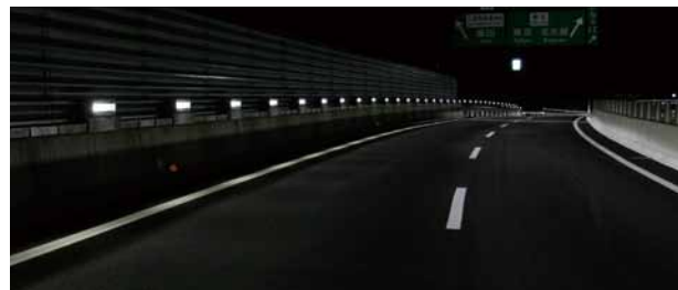
低位置照明の設置状況
