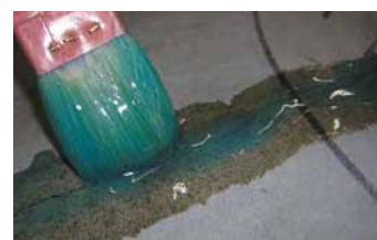
ひび割れ浸透接着剤施工状況
