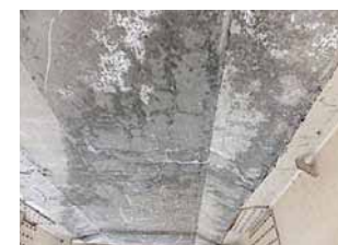
橋梁の損傷事例/ 床版下面のひび割れ・遊離石灰
