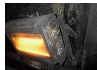
施設設備の損傷事例/ 道路照明の腐食
