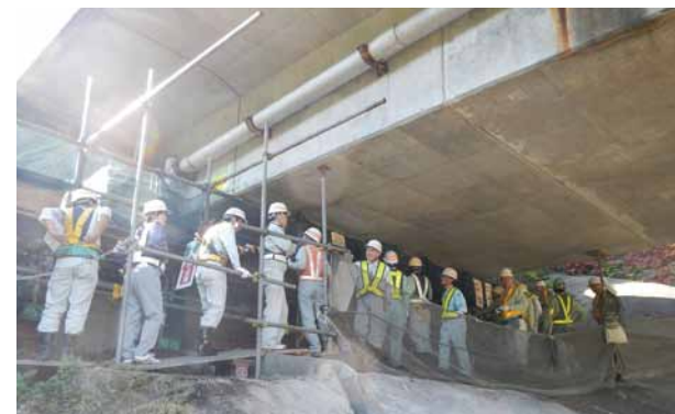
橋梁支承補修工事現地視察の様子
