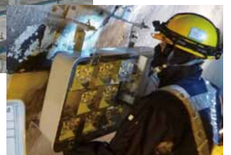
照明設備の取換え
