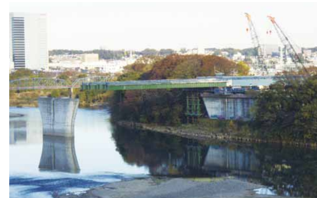
相模川の中に重機を入れずに橋桁を送り出す様子
