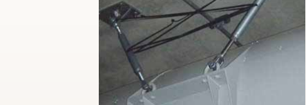
ジェットファン落下防止対策(紀勢道)(ワイヤーによる固定)
