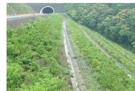
のり面の樹林化(建設時)
