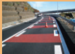
速度抑制のための薄層舗装
