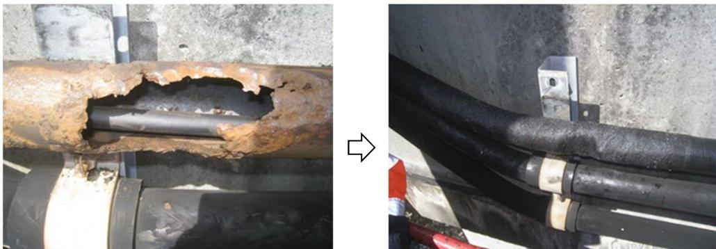
【速やかな対策が必要な変状の措置事例(ケーブル用配管の破損)】
