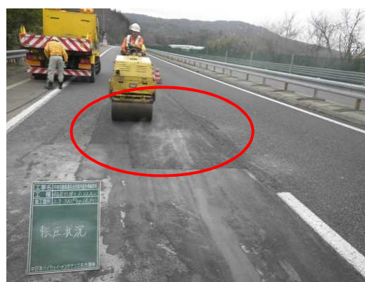
【舗装の転圧作業】
