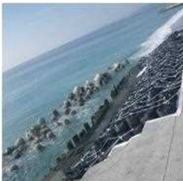
【大型土のう設置完了】
