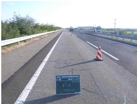
【舗装補修(施工前)】
