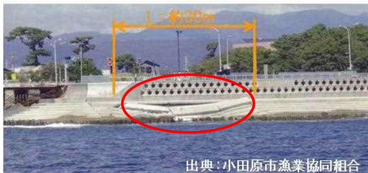
【盛土のり面の崩落】
