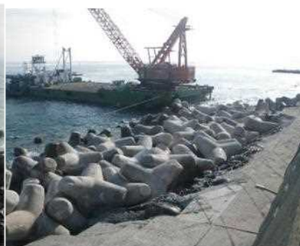
【応急復旧対策の完了】
