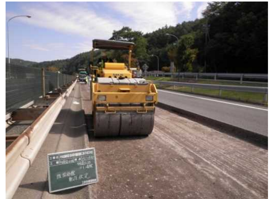
【舗装計画保全の事例(深層部含む打換え)】
