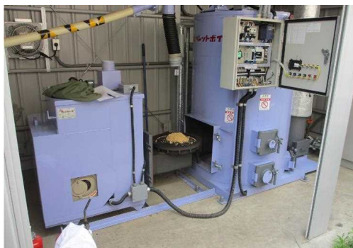
【ペレットをボイラーで燃やして空調などに利用】
