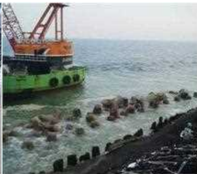
【消波ブロック設置完了】
