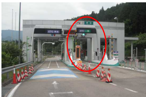
【ETCバックアップレーン整備】 (東海北陸自動車道:美並IC)
