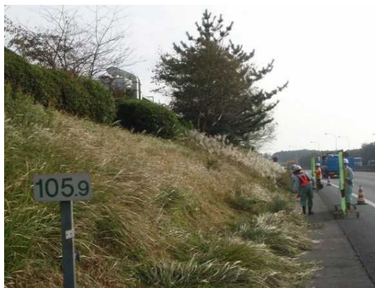
【草刈作業(東名愛鷹PA付近)】
