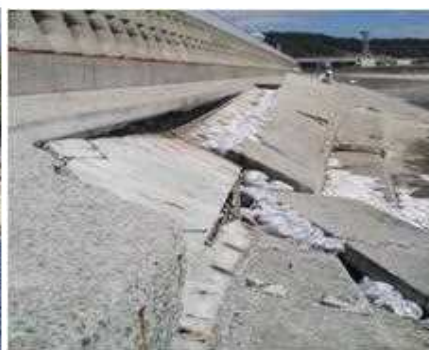
【護岸変状状況】
