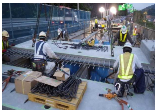
【橋梁の床版取替え工事状況】
