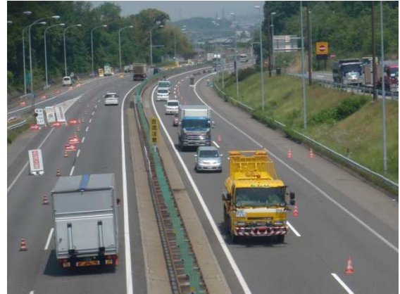
【名神集中工事の規制状況】
