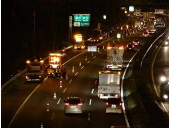
【東名集中工事の規制状況】
