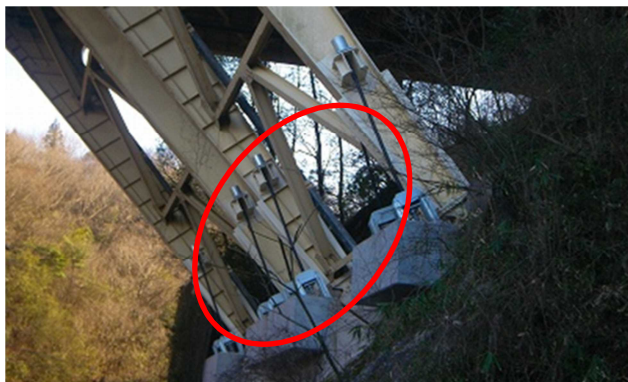
【落橋防止のための上揚力抑制装置の設置】
