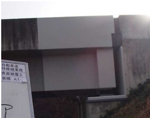
【橋梁計画保全の事例(桁端部の補修)】
