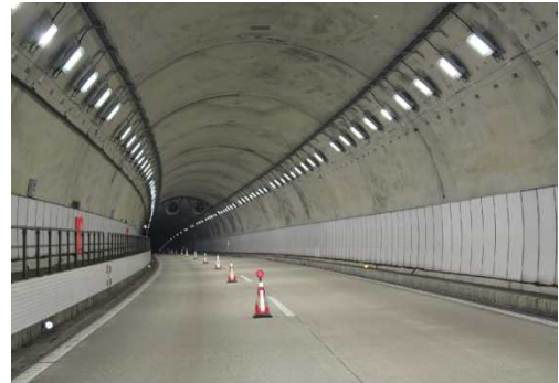
【更新後(LED照明)】
