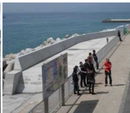
【復旧した護岸工(PAから望む)】
