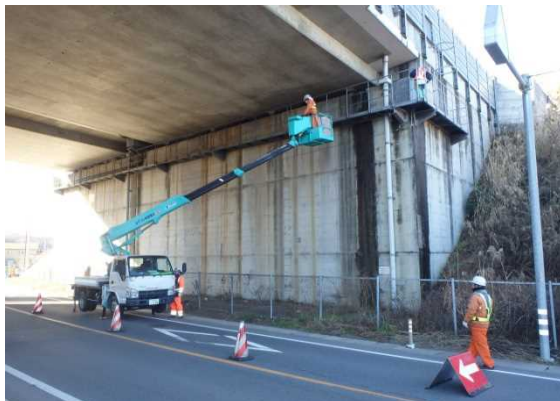
【橋梁における点検実施状況】
