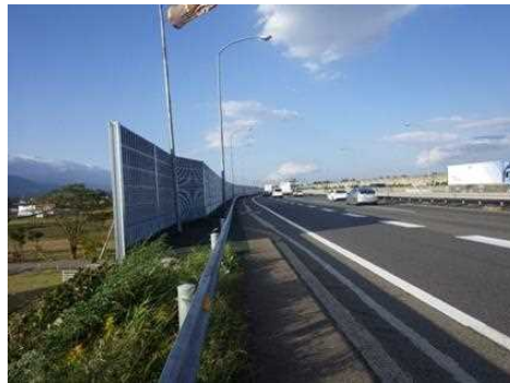
【遮音壁 施工後】
