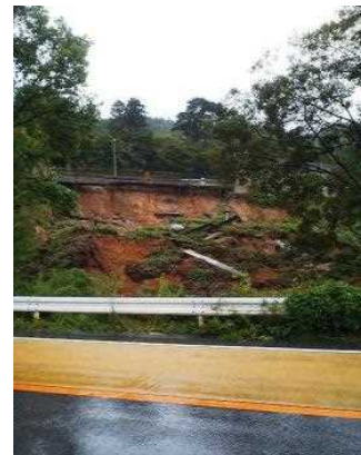
【被災状況(全景)】
