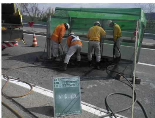
【痛んだ舗装路面のはつり作業】
