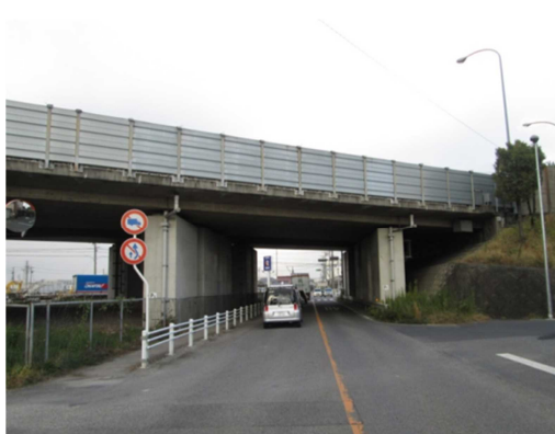
【剥落対策工(連続繊維シート)施工後】
