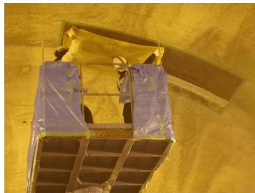
【コンクリート剥落対策工事】
