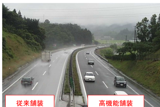
【密粒舗装と高機能舗装の状況写真】
