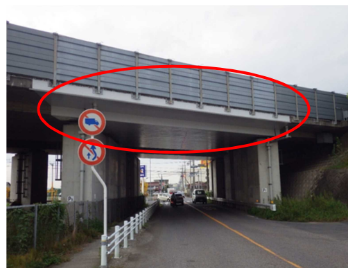
【剥落対策工(連続繊維シート)施工後】
