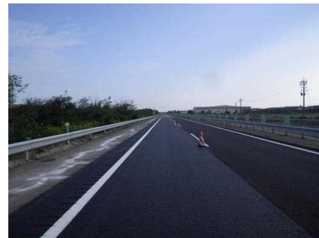
【舗装補修(施工後)】
