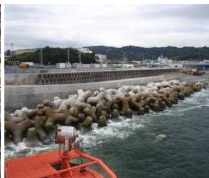
【復旧した護岸工(海上より望む)】
