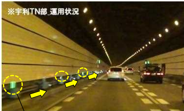
トンネル内設置状況
