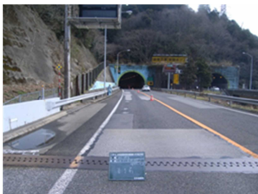
《舗装補修(施工前)》
