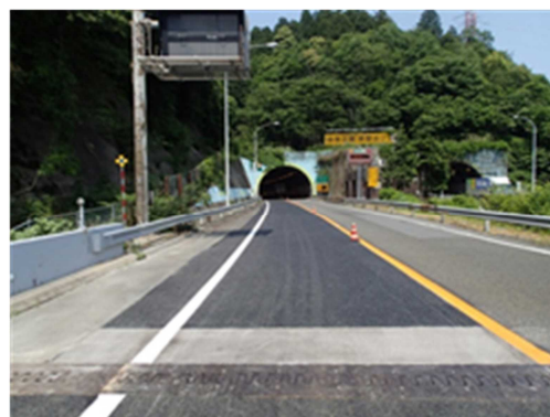
《舗装補修(施工後)》
