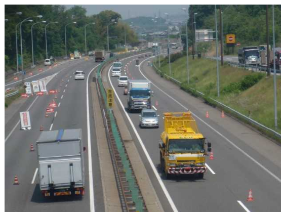
<名神道集中工事の規制状況>
