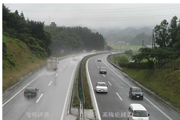
《密粒舗装と高機能舗装の状況写真》
